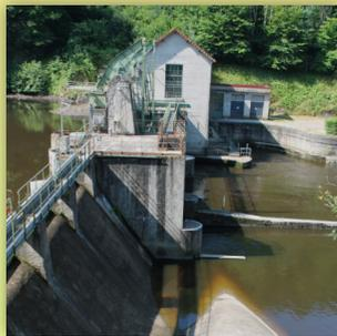
Il a été bâti en 1931. Il fait partie d'un ensemble de sept barrages dans le Morvan. C'est le plus petit. Il est en bon état et toujours en fonctionnement. Il a une chute d'eau de 6 m. Il produit de l'électricité, mais permet aussi de réguler les débits de l'Yonne et de la Seine.
